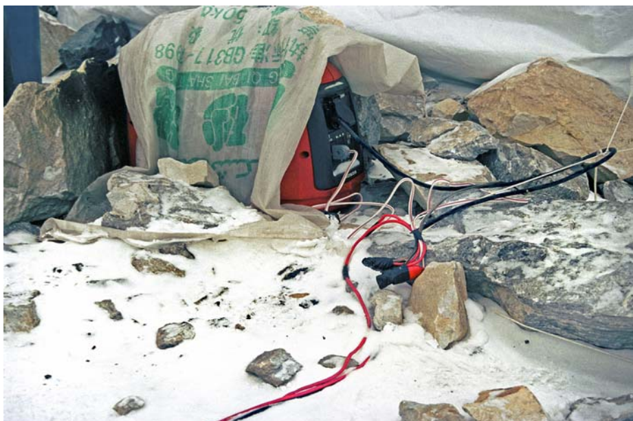
Rys.2 Agregat prądowórczy połączony przewodem OLFLEX® HEAT 180 EWKF 2x0,75mm 2
